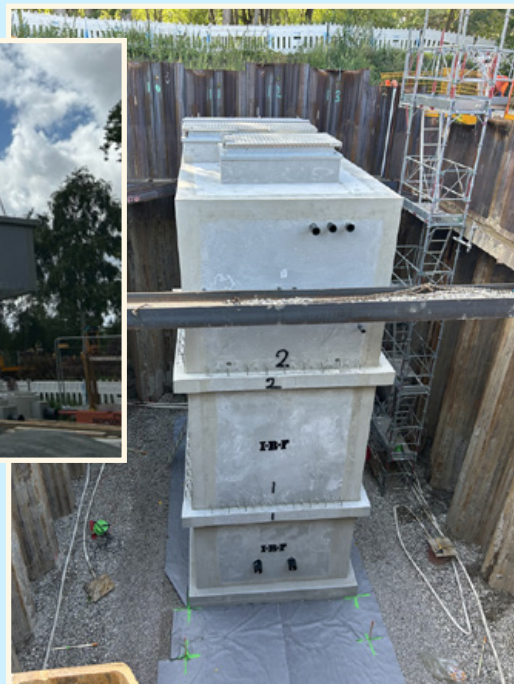
Her bliver elementerne til pumpestationen hejst på plads på parkeringspladsen for enden af Langhusvej
