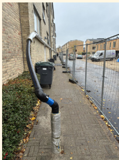
Midlertidig vandleddning i Bygårdstræde. Vandet er omlagt, mens det gamle, slidte jernrør, der har forsynet boligerne med vand, bliver udskiftet.
