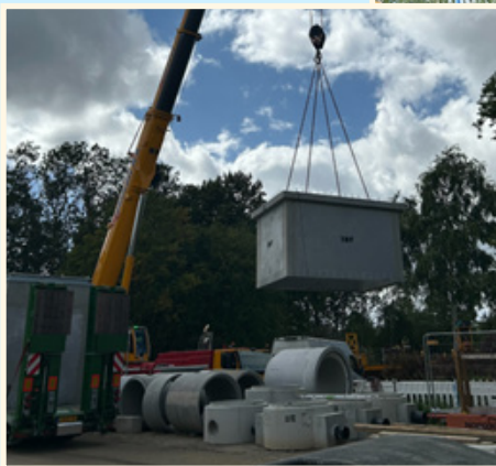
Her bliver elementerne til pumpestationen hejst på plads på parkeringspladsen for enden af Langhusvej
