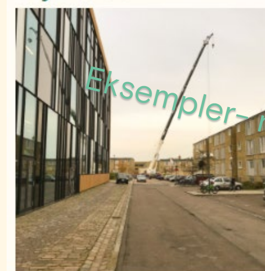
Seneste nyt fra byggepladsen ved Store Torv.
