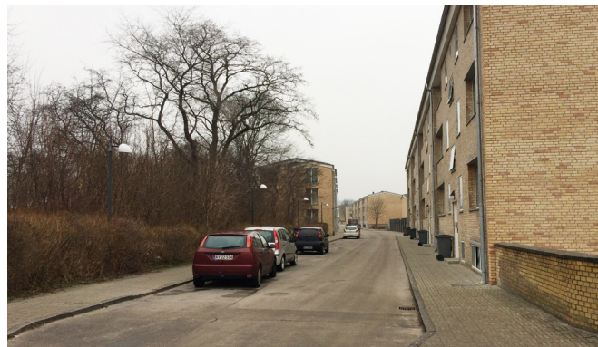
Kig ned af Bygårdsstræde mod nord.
