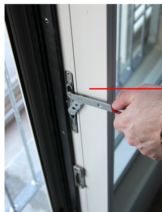
Grebet med den røde markering trækkes op til vandret
