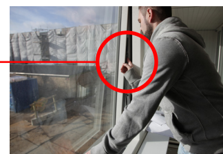
Børnesikringen udløses ved at presse beslaget opad
