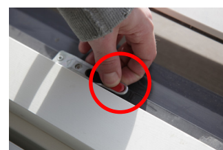
Den røde plastspærre fjernes
