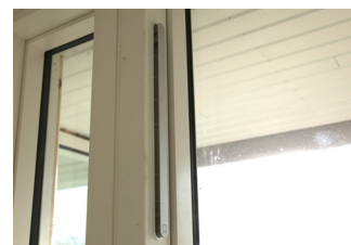
Udluftningsventil - i åben position
