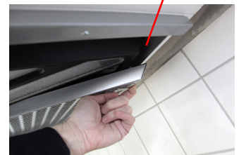
Tryk på låsene bagved for at løsne filteret
