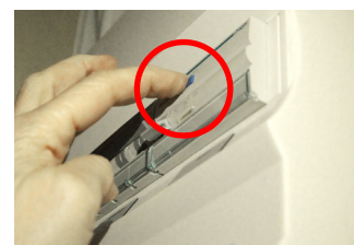
Den blå testknap trykkes ind for at afprøve HPFI-relæet
