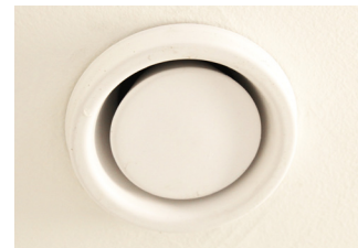
Udsugningsventil i loftet
