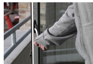
Enkeltdør, sidehængt og udadgående - lodret greb i åben position, døren fastholdes
