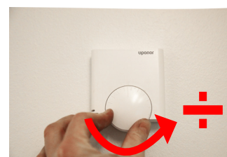
Drej termostatknappen MOD uret for at opnå en højere temperatur
