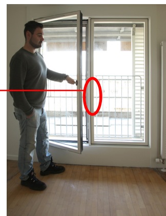
Dobbeldør, sidehængt og indadgående - åbning af siden uden greb
