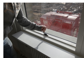
2. Greb i midterposition = åbning 2-4 cm
