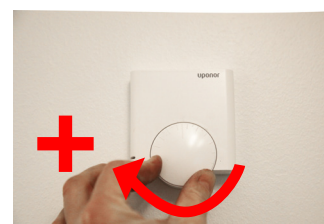
Drej termostatknappen MED uret for at opnå en højere temperatur
