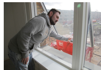
1. Børnesikringen er udløst og vinduet kan åbnes helt
