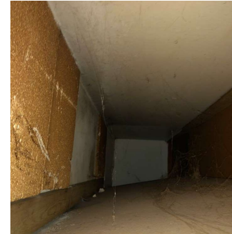
Hulrum over inddækning
