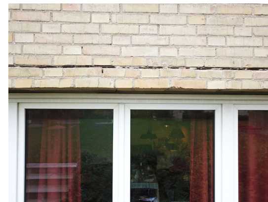
Eksempel på tegloverligger med slip i lejfuge.
