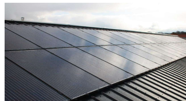
Eksempel på tag med solceller der er udlagt i et UBRUDT felt fra GAVL TIL GAVL
