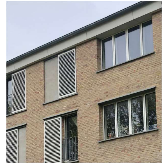
Stern - renovering et andet sted i Tingbjerg (Helle vold/Hækkeborg, afd. I)
