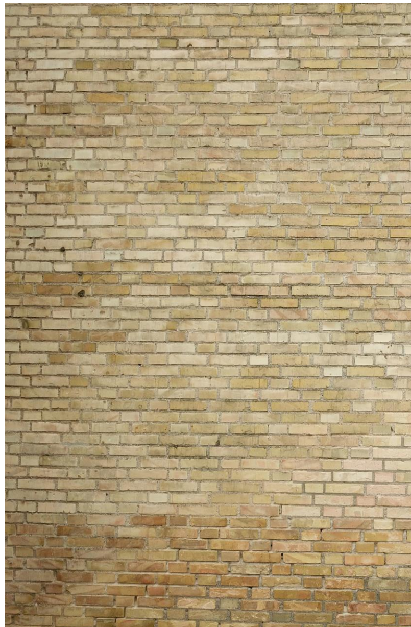
Eksempel på eksisterende murværk med opfugtning ved nederste del
