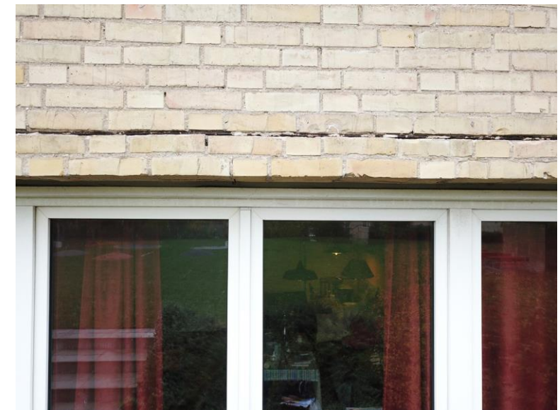
Eksempel på tegloverligger med slip i lejefuge.
