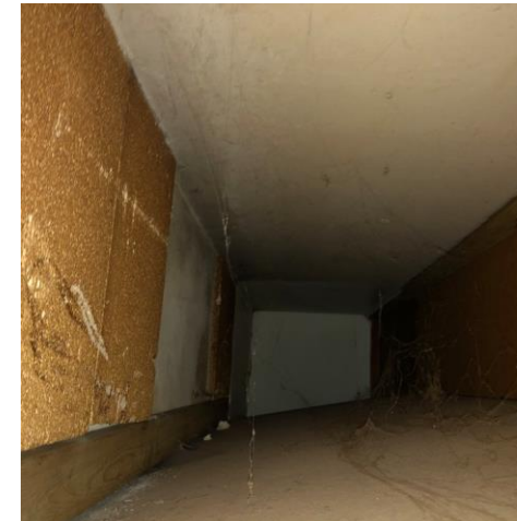
Hulrum over inddækning
