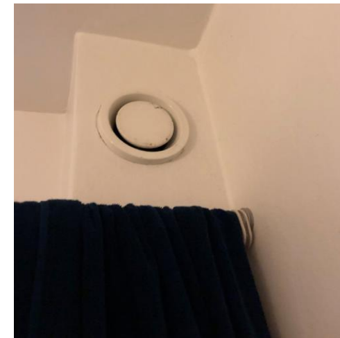
Udsug i indstøbte kanaler. Utilstrækkelig sug.
