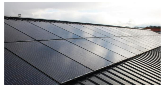
Eksempel på tag med solceller der er udlagt i felter.
