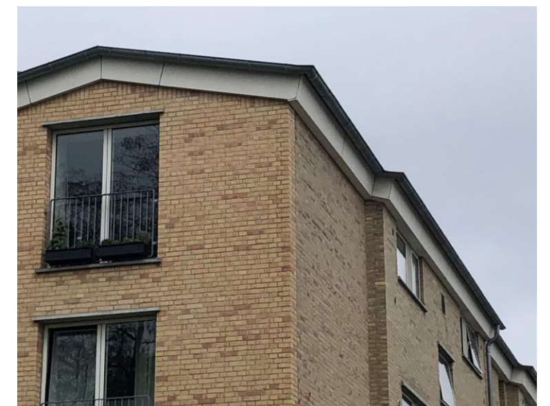
Vindske - renovering et andet sted i Tingbjerg / (Helle vold-Hækkeborg, afd. I)
