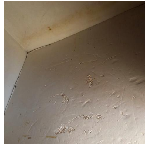
Indbygningsskab i soveværelse
