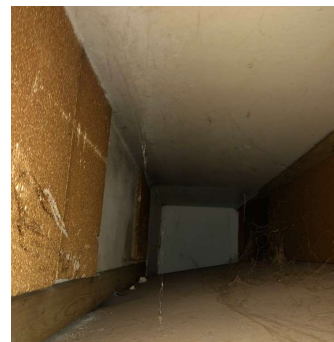
Hulrum over inddækning
