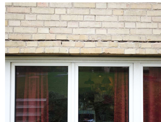
Eksempel på tegloverligger med slip i lejefuge.
