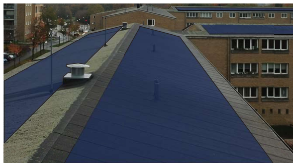
Eksempel på eksisterende tag- udlægning af solcelleanlæg markeret
